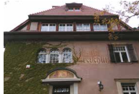
Die historische Villa Freischütz von außen
