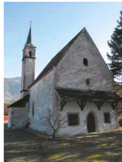
Die St. Agatha Kirche mit dem erneuerten Kirchturmhelm
